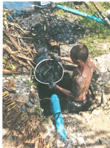
รูปภาพที่ 2.18 การขุดลอกรางระบายน้ำ
