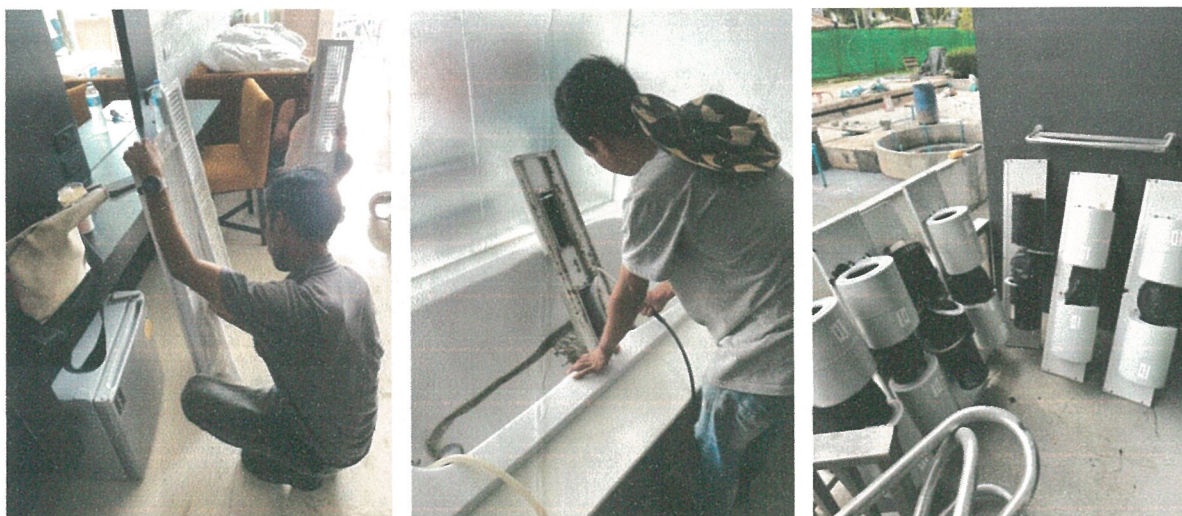
รูปภาพที่ 2.46 การล้างเครื่องปรับอากาศ
