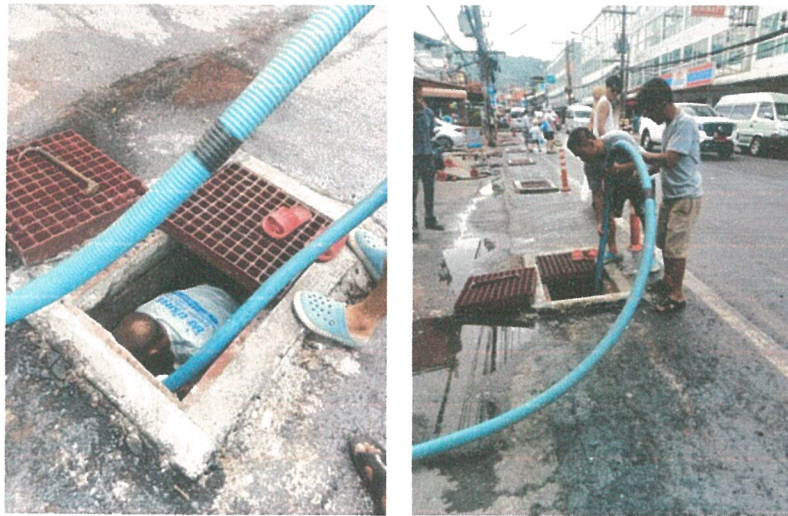
รูปภาพที่ 2.56 การสูบน้ำ
