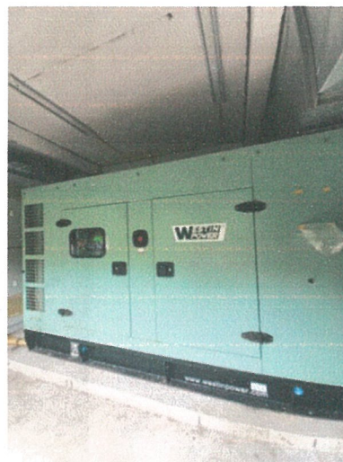
รูปภาพที่ 2.49 เครื่องกำเนิดไฟฟ้าสำรอง
